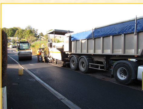
REFECTION DES VOIRIES
