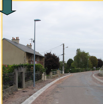
Enlèvement des anciens poteaux Le nouvel éclairage public
