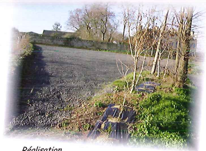
Réalisation d'un parking à côté du cimetière.
