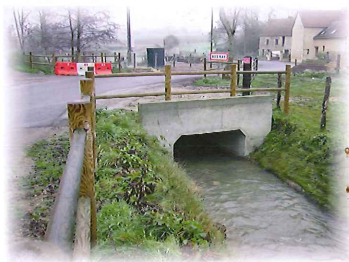
Réfection du Pont sur la Guigne, en limite d'Esquay Notre-Dame.
