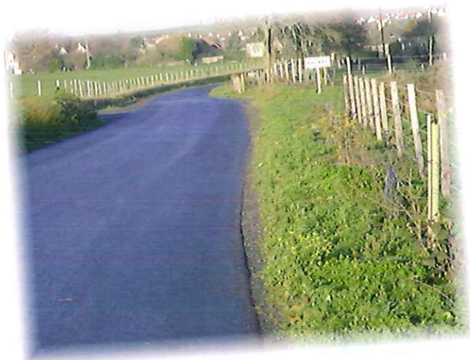
Élargissement de la chaussée, Route d'Esquay Notre-Dame et Route d'Amayé-sur-Orne.
