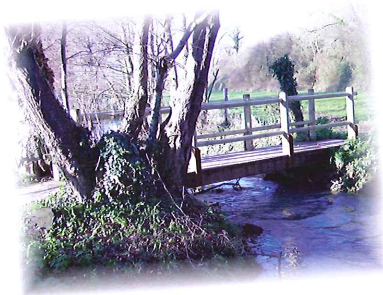
Création d'une passerelle sur la Guigne, au bout du Chemin du « Moulin Michel ».
